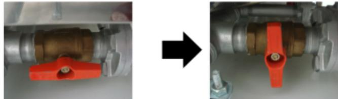
3. A, B 水槽のバルブ（図 1-A, B）を開け水を溜める。
