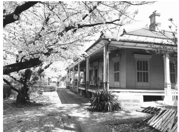
写真1 国指定重要文化財東山手十二番館
